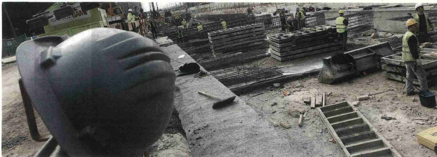
Vista de una obra en Barcelona. LUIS MORENO
